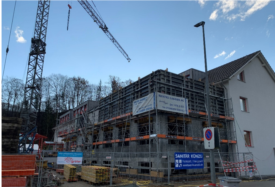
Stand Erweiterungsbau 17. Dezember 2020
