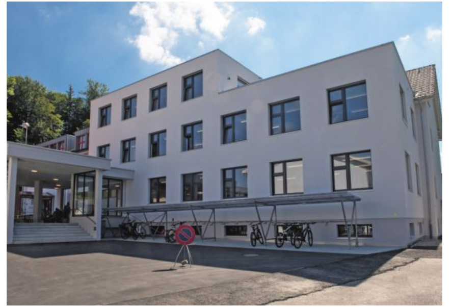
Es scheint, als stünde der Erweiterungsbau schon seit Jahren hier.
